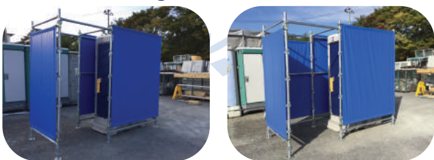
⑧ 出入口の目隠し
